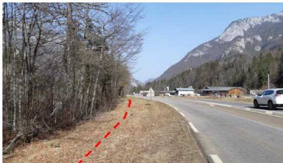
Conduite enfouie en accotement de la route départementale (ou en-dessous)
